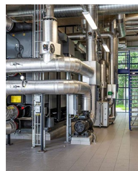
Kølevarme fra Topsøe udgør mere end halvdelen af fjernvarmen i Frederikssund By.
