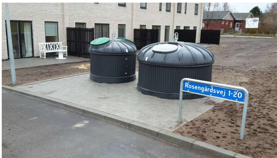
Foto: Beholdere til madaffald og restaffald på Rosengårdsvej. Her i hver sin delvist nedgravede beholder fra leverandøren Eurogroup.
