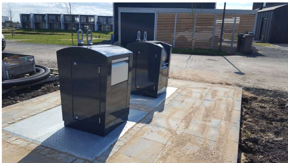
Foto: Beholdere til madaffald og restaffald på Obvej. Her i hver sin fuldt nedgravede beholder fra leverandøren Rubæk.
