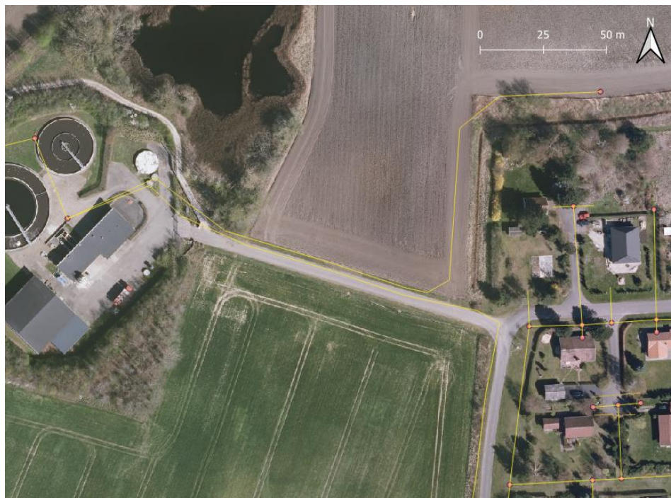
Figur 2.17: Spildevandsledninger ejet af Novafos ved adgangsvejen til renseanlægget. Ortofoto: 2019.
