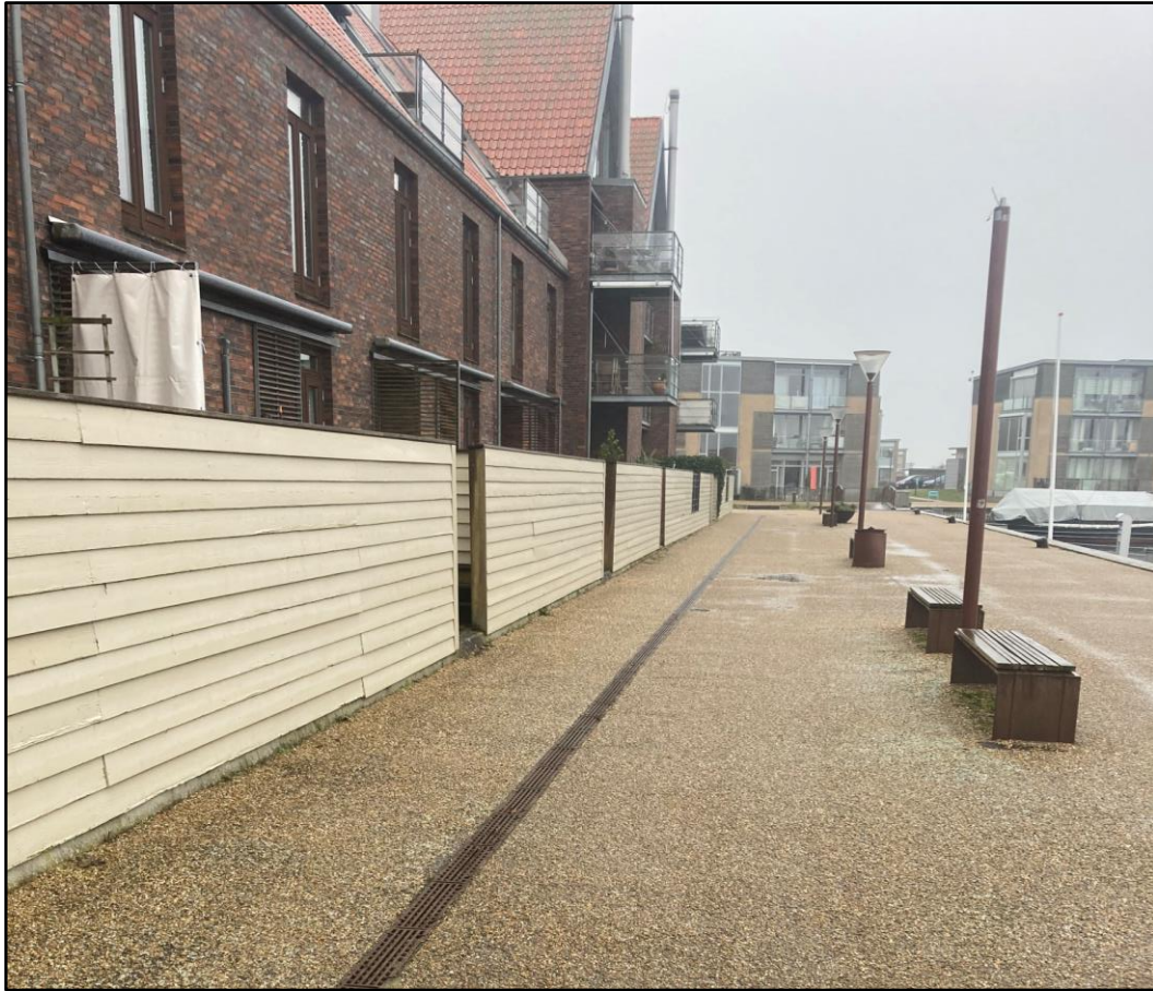
Figur 3.1: Rækværk og indgange ind til Amsterdamhusenes terrasser vist fra gangarealet langs kajen. Foto: NIRAS 12-03-2023.
