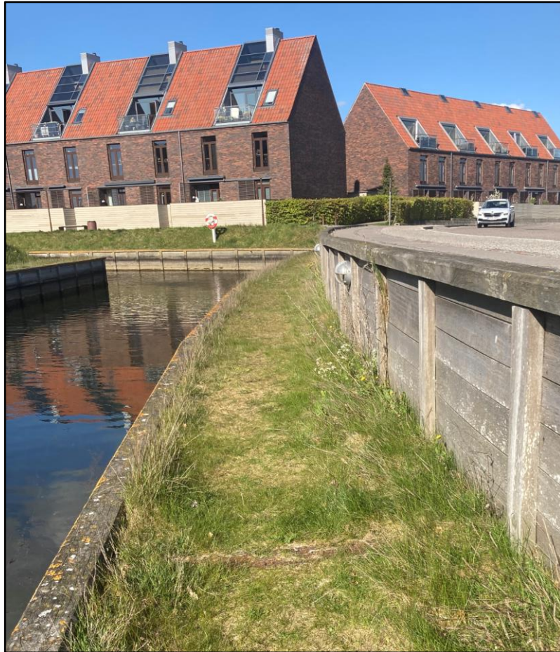
Figur 3.5: Spunvæg langs Stenværksvej. Foto: NIRAS d. 11-05-2023.
