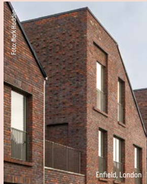
Enfield, London Eksempel på facade i tegl
