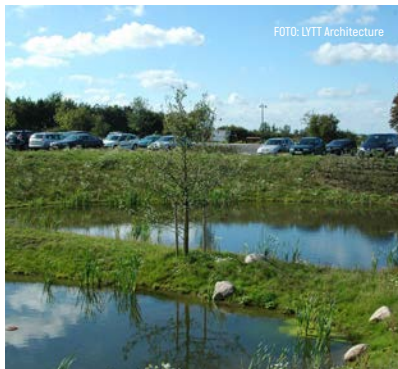
Parkering med integreret regnvandshåndtering
