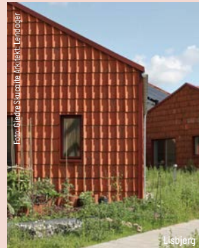
Lejlsjerg Eksempel på facade i teglsten
