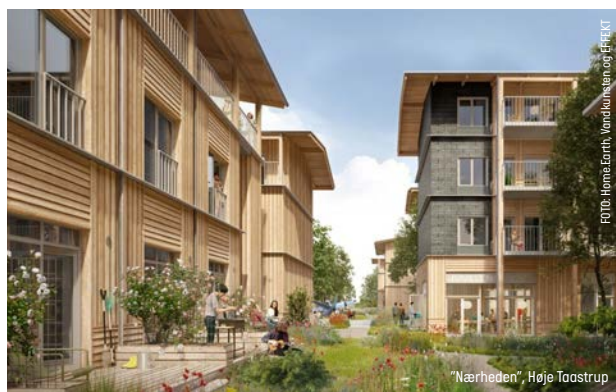
Home.Earth er gået sammen med Scandi Byg, i opførelsen af modulære bygninger med lavt CO 2 -aftryk. Nærheden er et flagskibsprojekt for Home.Earth, der kombinerer ambitioner på tværs af bundlinjer: fra et markedsledende CO 2 -fodaftryk under 6 kg/m 2 /år til en ambitiøs social dagsorden. 2
