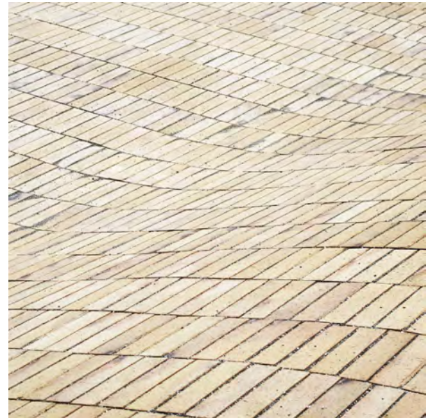
Belægning i kulbrændte gule klinker, der danner terrænbølger
