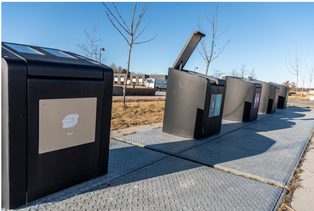
Nedgravede affaldscontainere i Vinge. Foto: Kenneth Jensen.
