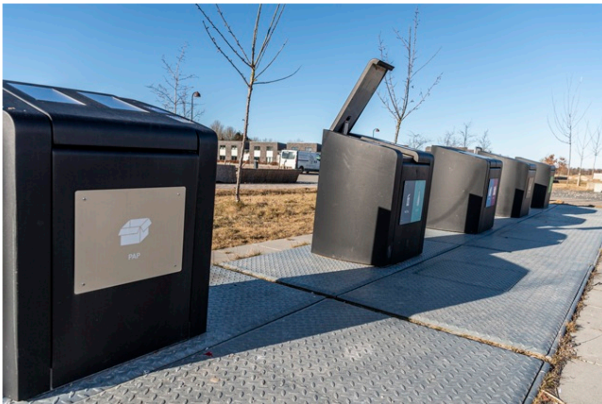
Nedgravede affaldscontainere i Vinge. Foto: Kenneth Jensen.
