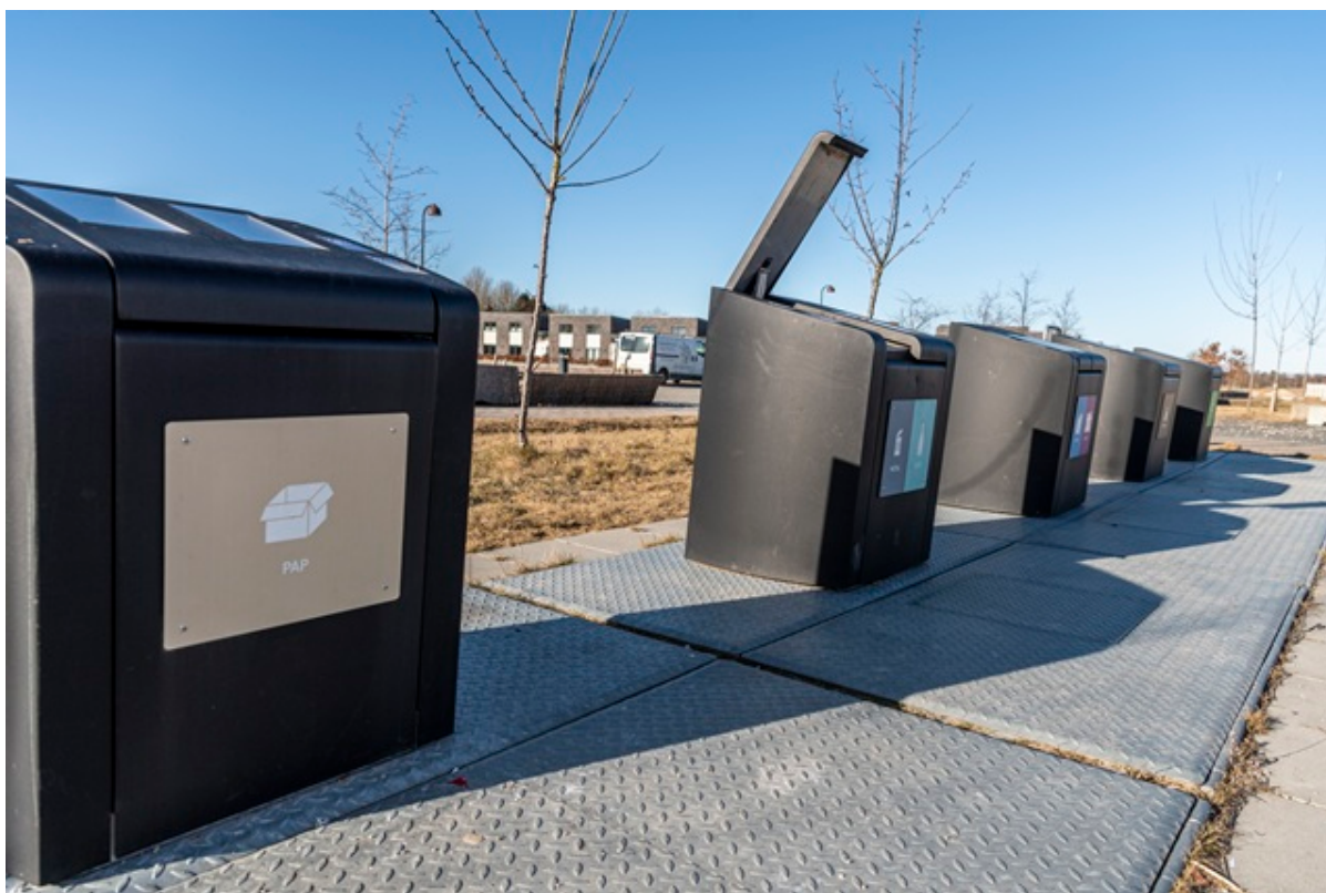
Nedgravede affaldscontainere i Vinge. Foto: Kenneth Jensen.
