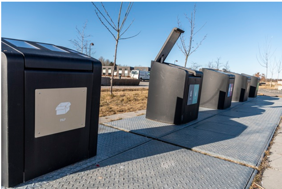
Nedgravede affaldscontainere i Vinge. Foto: Kenneth Jensen.
