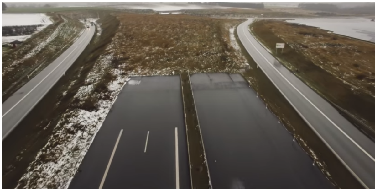
Frederikssundmotorvejens slutning ved Smørum. Foto: Frederikssund, Egedal og Ballerup Kommuner.
