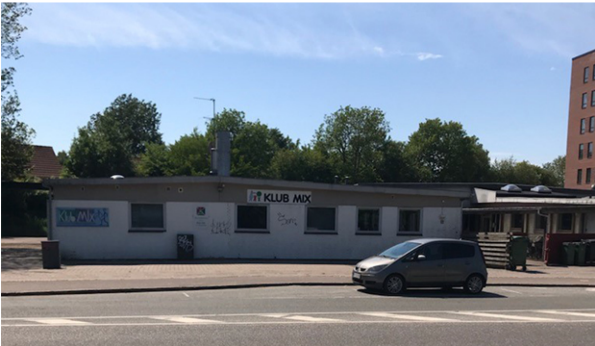
Facaden af Klub Mix. Foto: Frederikssund Kommune.
