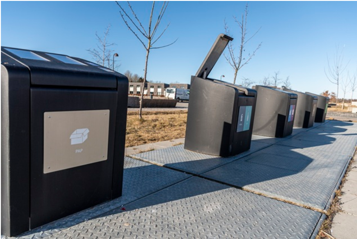
Nedgravede affaldscontainere i Vinge. Foto: Kenneth Jensen.
