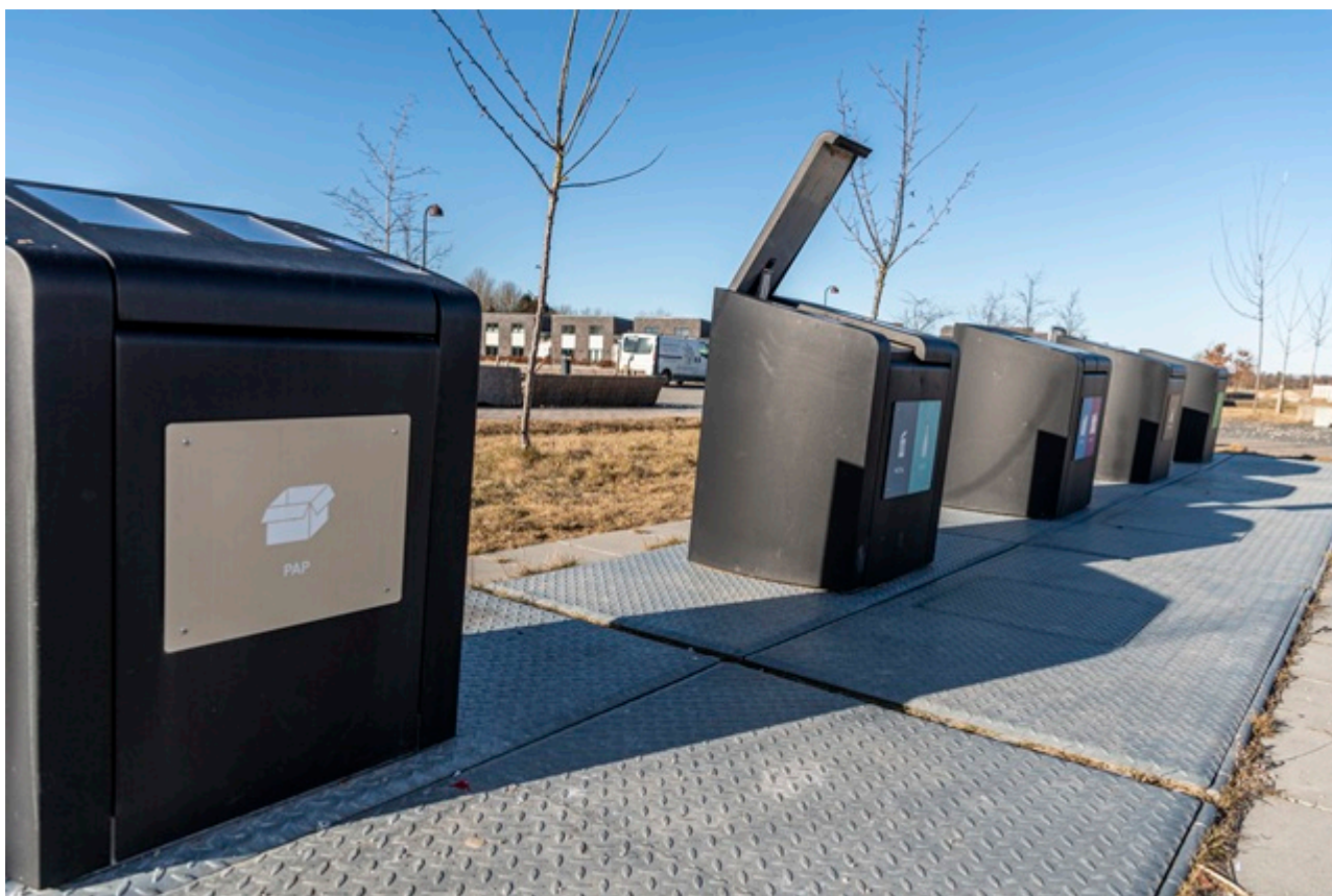
Nedgravede affaldscontainere i Vinge.
