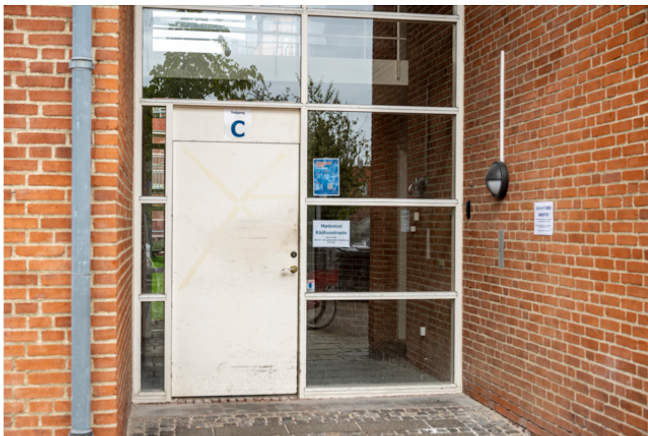
Indgang C fra Rådhusstræde på bagsiden af Rådhuset.
