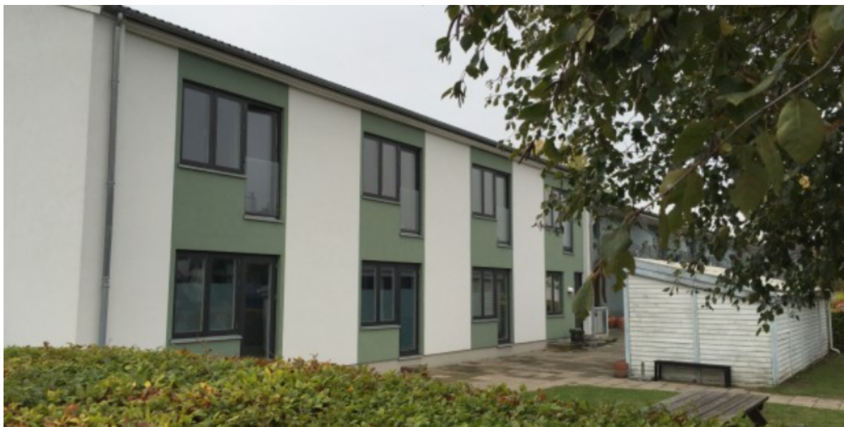
Ungdomsboligerne på Birkevænget. Foto: Frederikssund Kommune.
