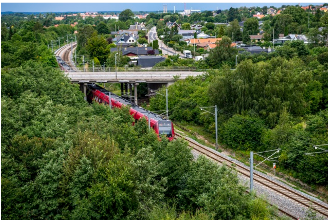
Jernbanebroen på Strandgade i Frederikssund.
