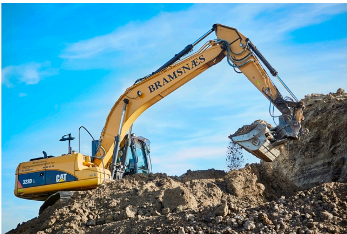
Gravemaskine graver i jorden. foto: Frederikssund Kommune.
