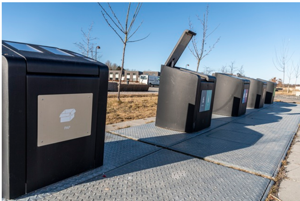
Nedgravede affaldscontainere i Vinge. Foto: Kenneth Jensen.
