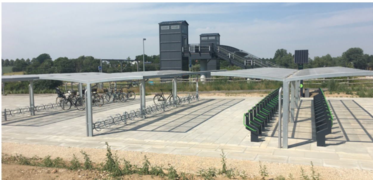
Ny overdækket cykelparkering ved Vinge Station.
