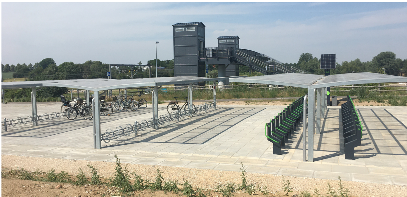
Ny overdækket cykelparkering ved Vinge Station.
