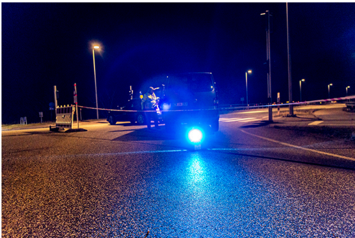
Kronprins Frederiks Bro er spærret. Foto: Kenneth Jensen, Frederikssund Kommune.
