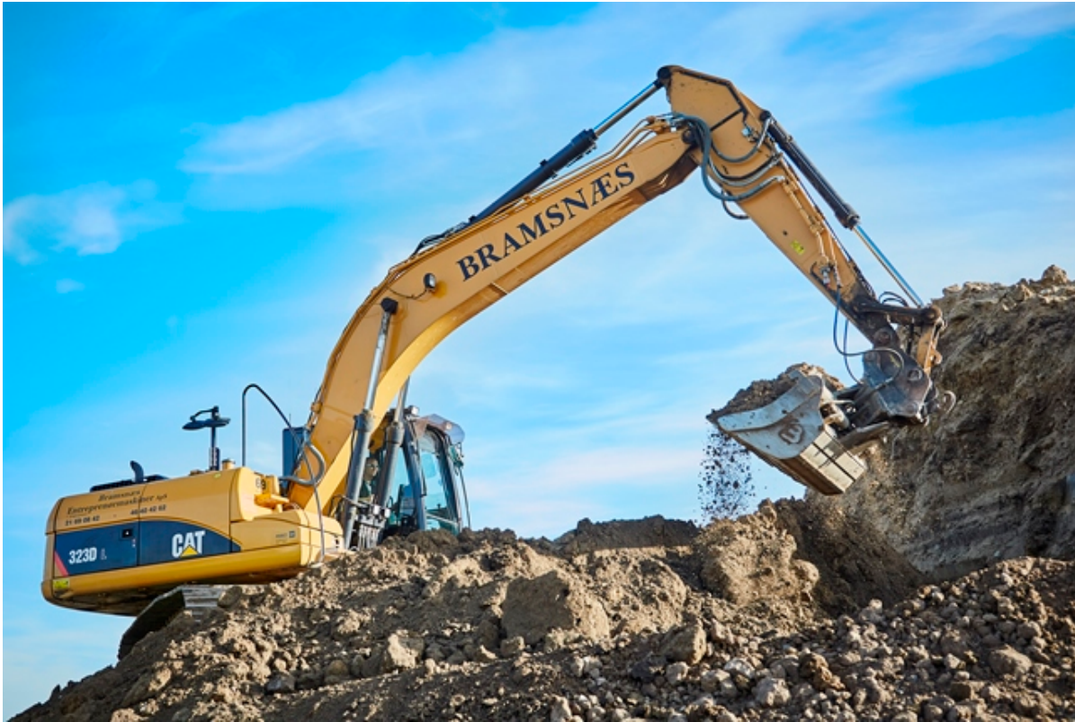
Gravemaskine flytter jord. Foto: Frederikssund Kommune.
