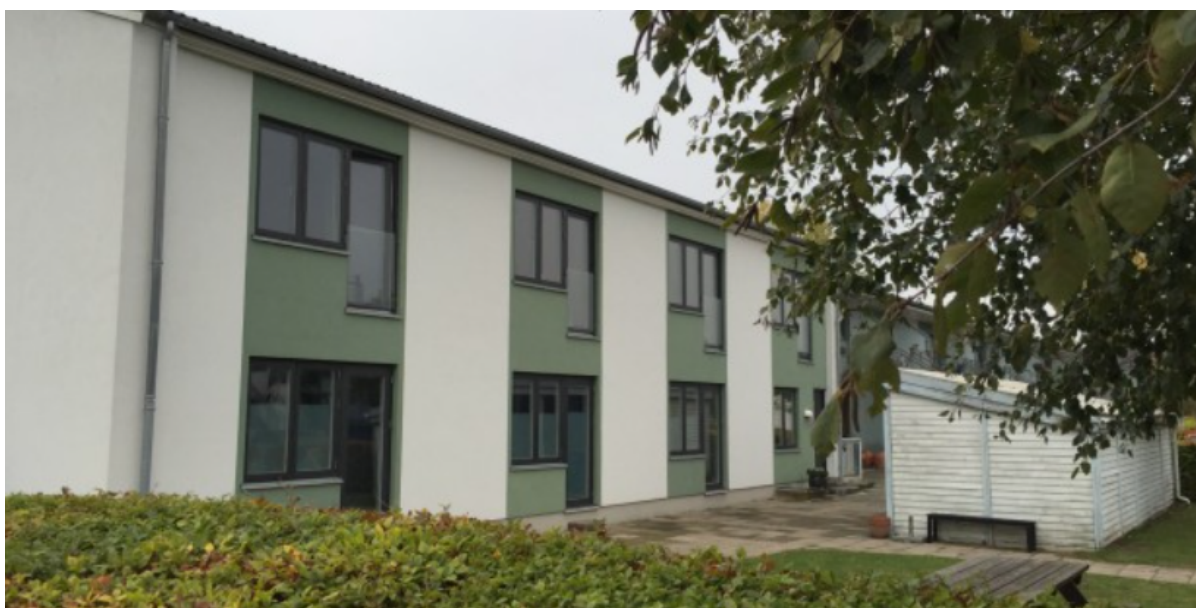
Ungdomsboligerne på Birkevænget. Foto: Frederikssund Kommune.
