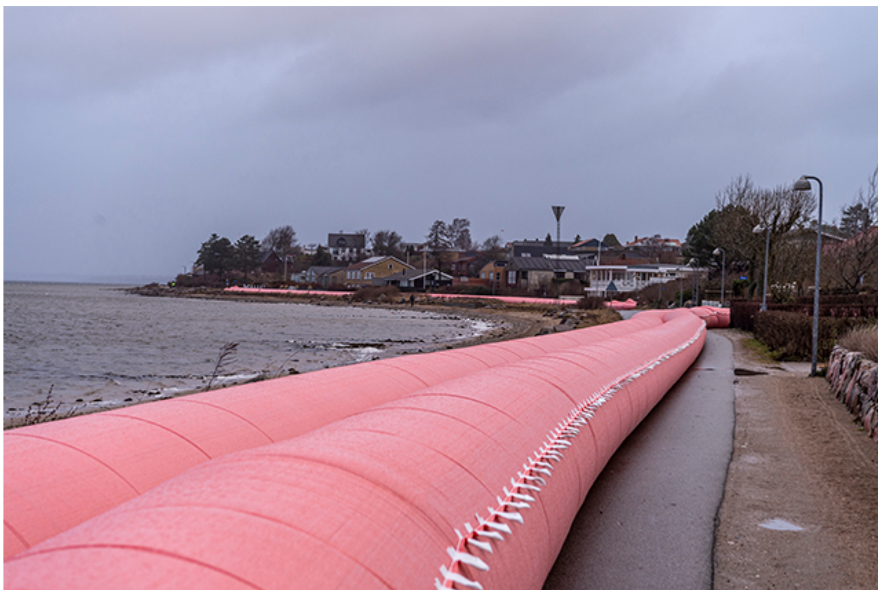
Watertubes på Strandvej i Frederikssund.
