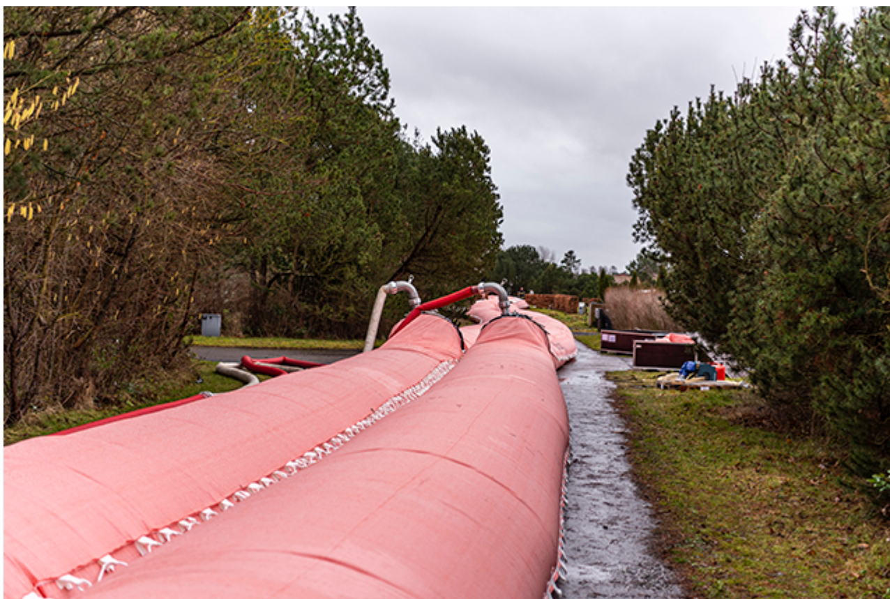
Watertubes i Hyllingeriis, der fyldes af Beredskabsstyrelsens enorme pumper.
