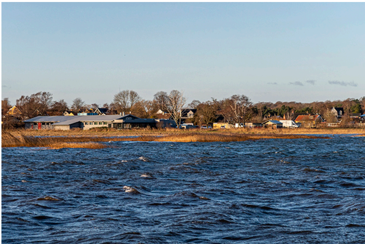
Tæt på og alligevel langt fra Kignæshallen denne gang, hvor vandet var adskillige meter fra Hallen og Smedeengen.
