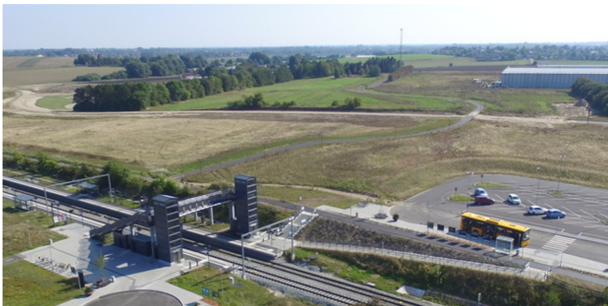
Vinge Station og p-plads. Foto: Frederikssund Kommune.
