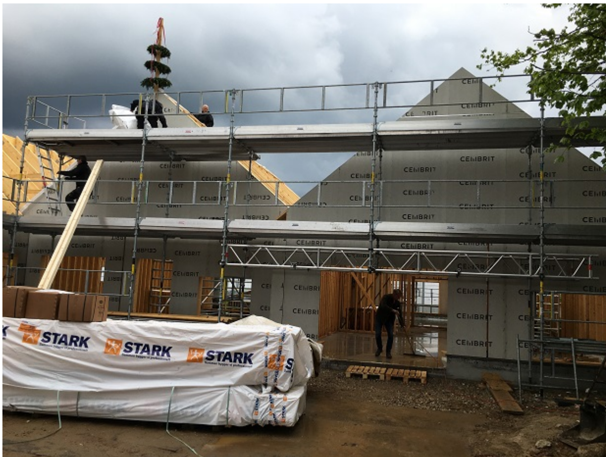
Facaden af det nye Børnehuset Gyldensten med rejsegildekrans rejst på taget.
