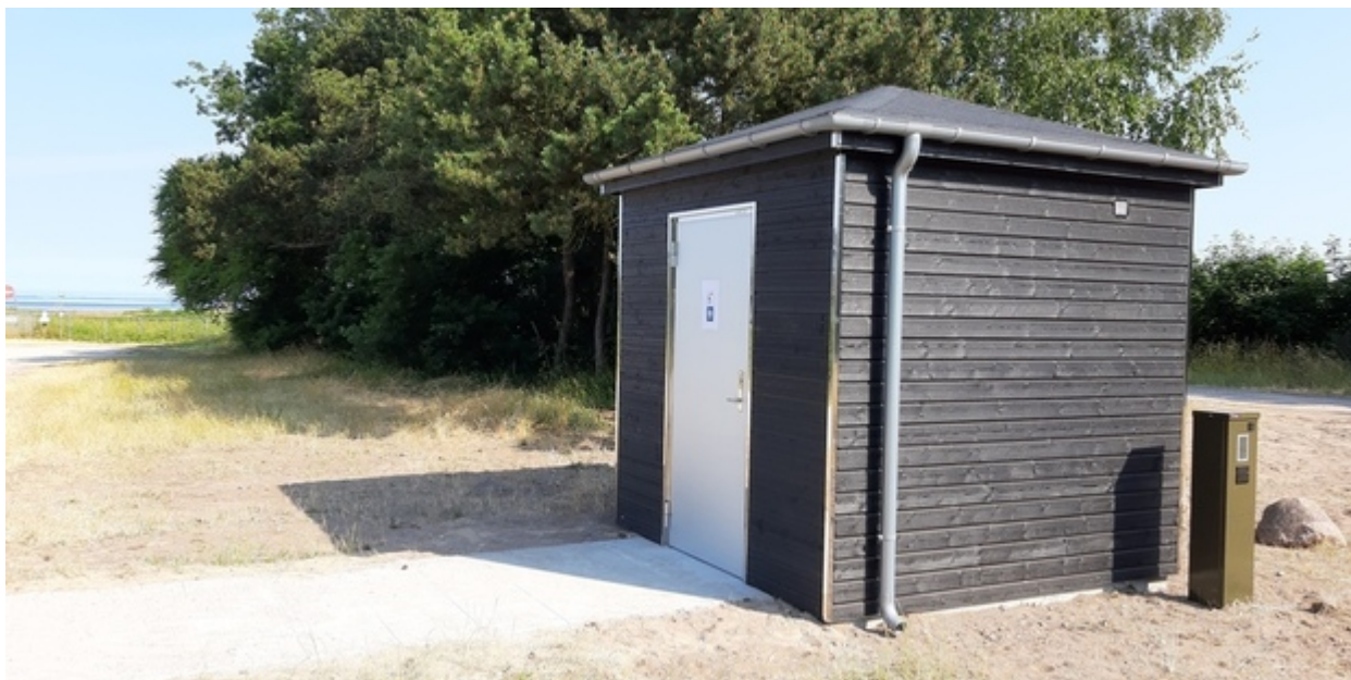
Toiletbygningen ved Dalby Huse Strand.
