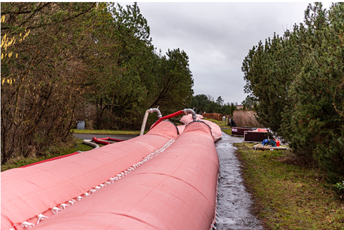
Watertubes i Hyllingeriis, der fyldes af Beredskabsstyrelsens enorme pumper. Foto: Frederikssund Kommune, Kenneth Jensen.
