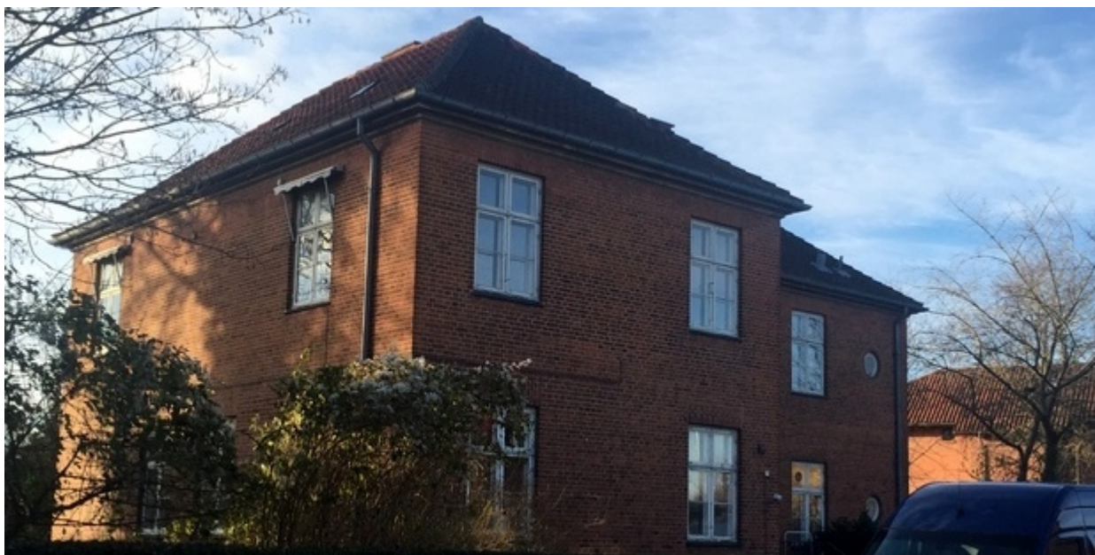
Huset på Lundevej 13.
