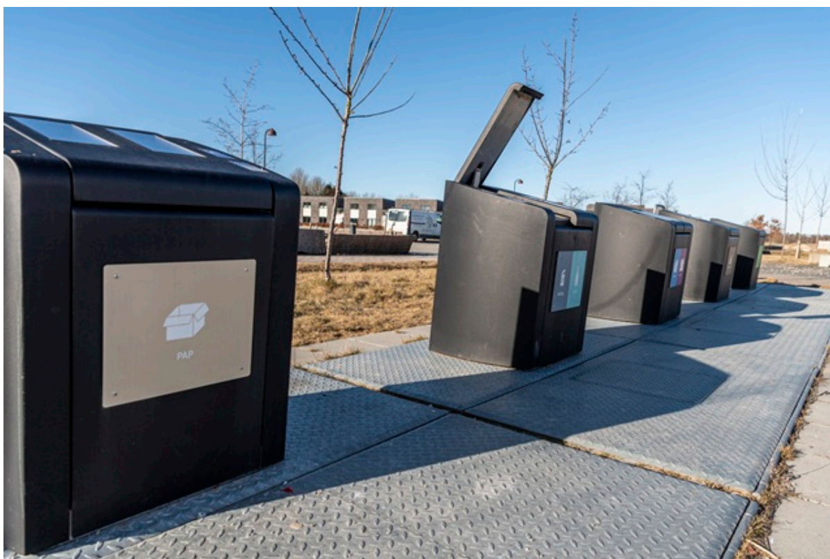
Nedgravede affaldscontainere i Vinge. Foto: Kenneth Jensen.
