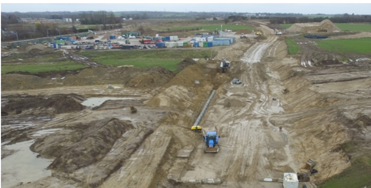
I den ene side af vejen lægges dræn, der skal føre regnvandet til et bassin i nærheden. Foto: Frederikssund Kommune, Steven Rønnenkamp Holst.
