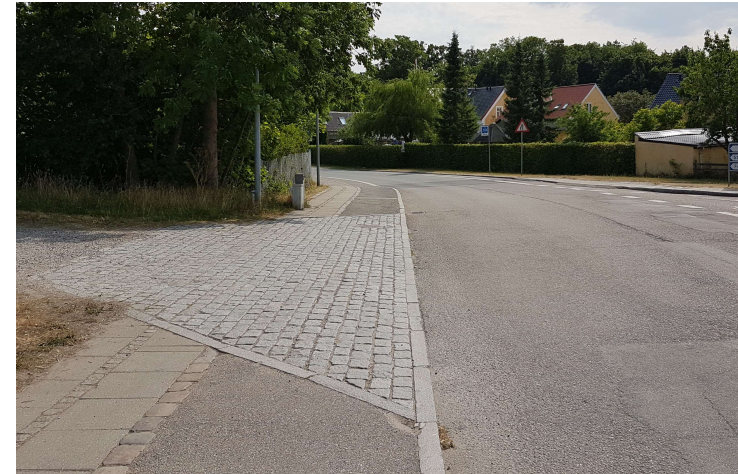
Brostenoverkørsel over cykelsti
