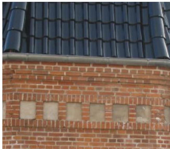
Gesimsbånd og murværksdetaljer
