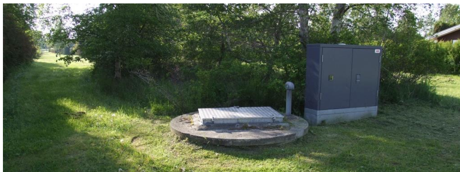
Figur 3-2: En af områdets spildevandspumpestationer.
