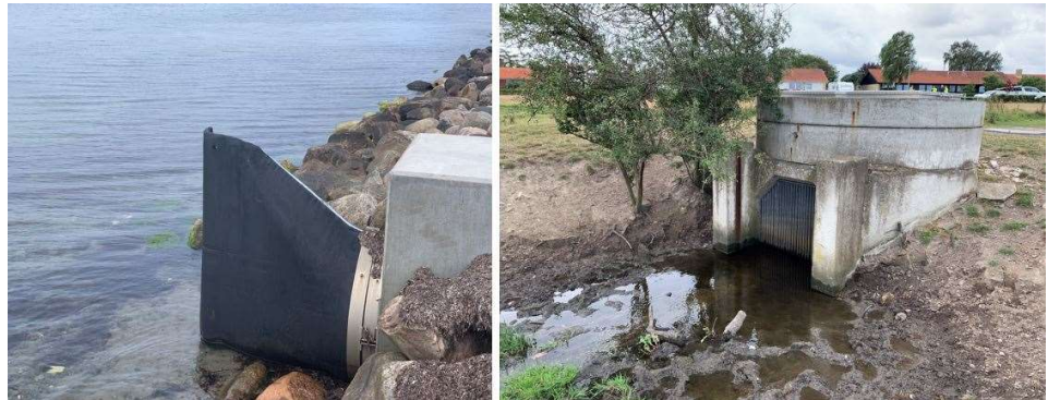
Figur 2.12: Nuværende udløbsbygværk ender i en metalrist inden udledning i grøft til Græse Å, se foto til højre.
