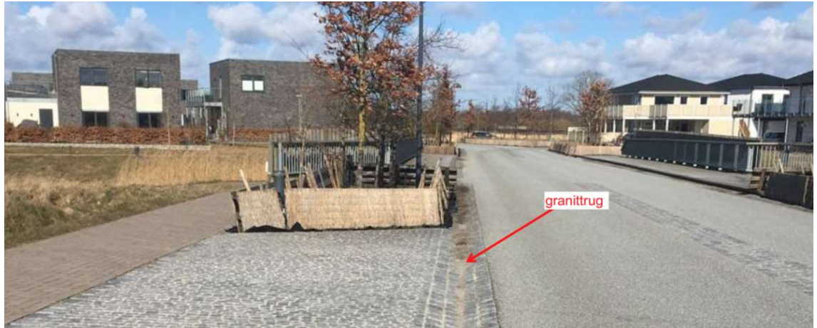
Figur 7 Granittrug langs asfaltareal på Deltavej.
