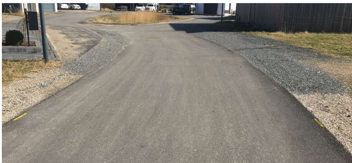
Figur 6 Asfaltvej. Der er 4 m imellem de gule streger. De gule striber skal bare illustrere bredden. De kommer ikke i det endelige projekt.
