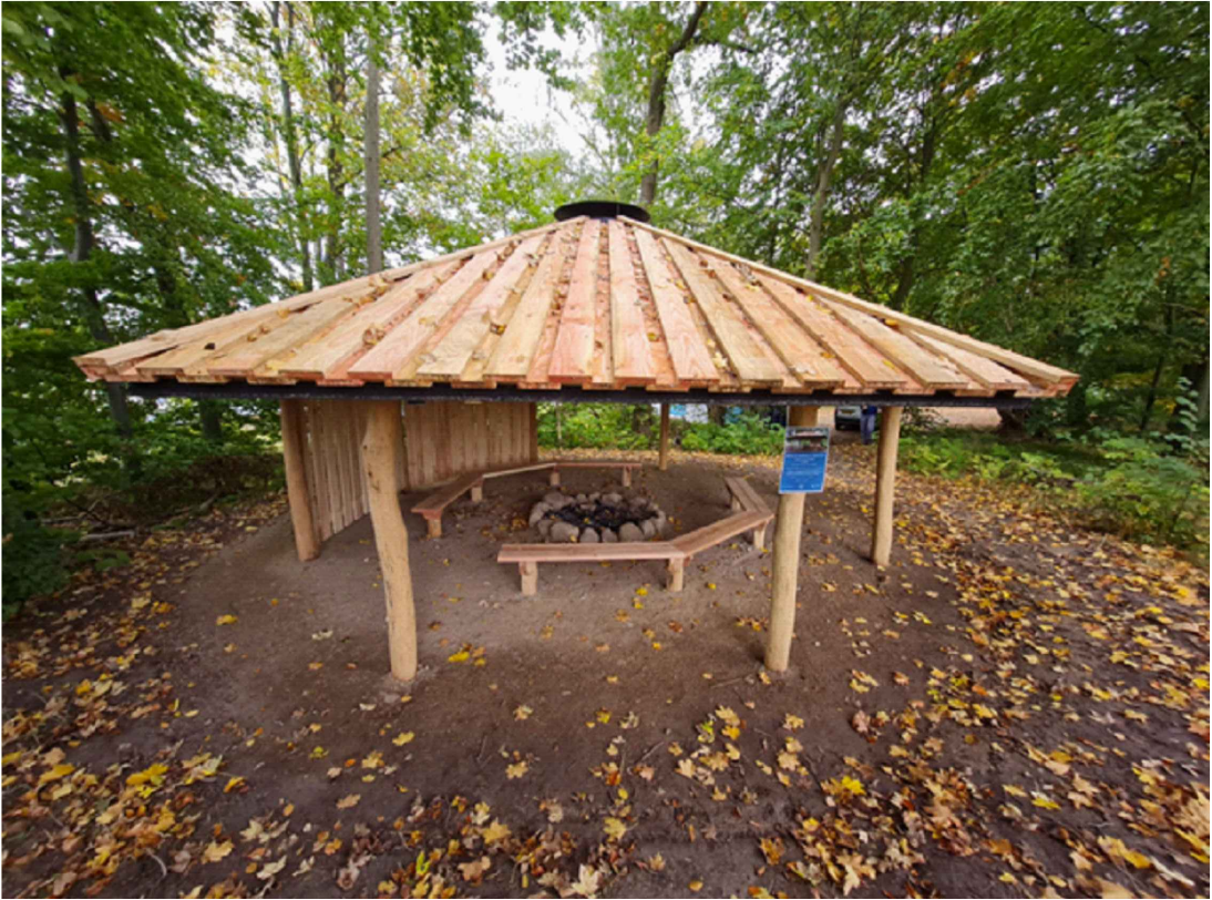
Bålhytte , eksempelvis som Naturstyrelsens bålhytte type 4, Størrelse = ø6m i diameter Højde ca. 3,5-4m. Bålhytten udføres i naturlige materialer tilpasset omgivelserne Stolper udført robinietræ og taget er udført i kalmbrædder i naturtræ som douglasgran eller lærk.
