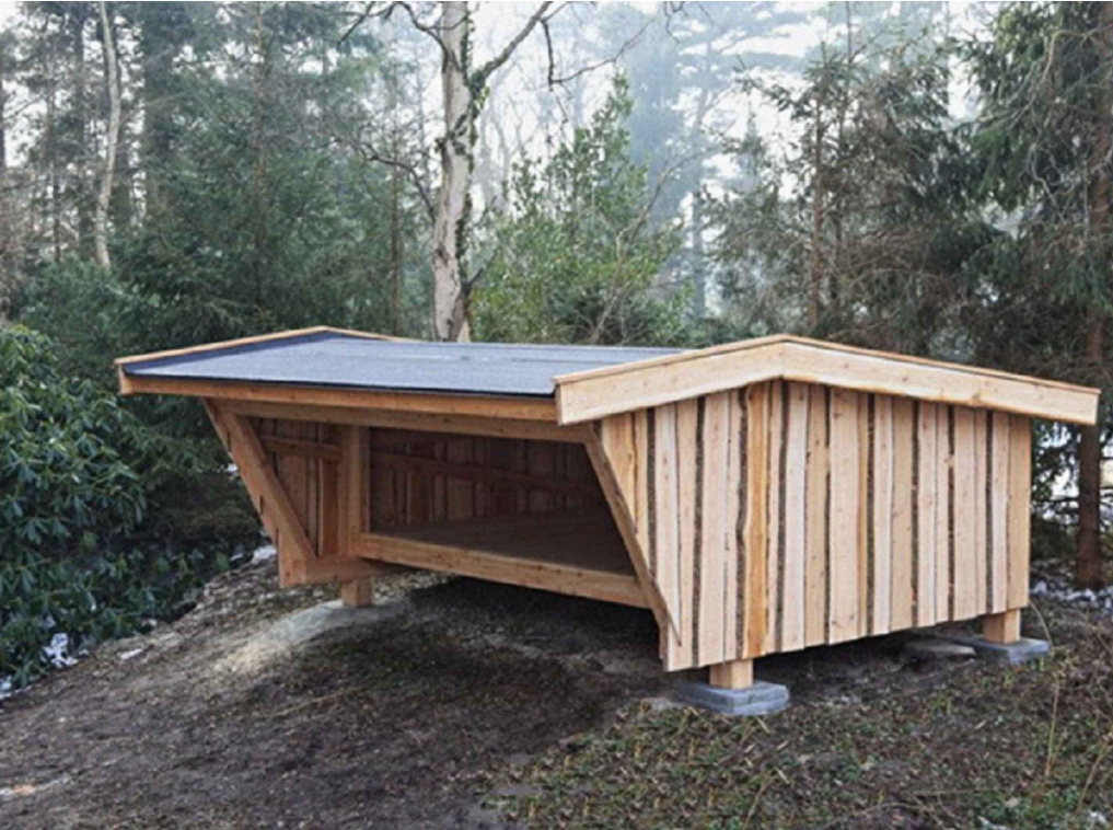
2stk. nye shelters, eksempelvis som Kalmar stor med saddeltag Størrelse = 2,5x4,5m2 med et udhæng på 1,4m Shelters udføres i naturlige materialer tilpasset omgivelserne, i tømmer, med facader af kalmarbrædder i lærk monteret en på to. Tag udføres med tagbrædder og sort tagpap.
