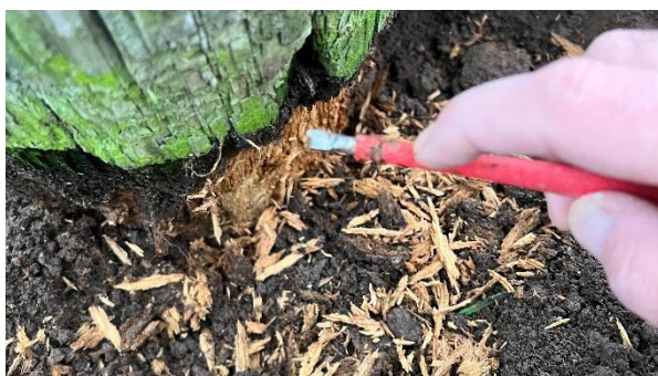
Foto 11 – Søjle 5 – Ingen modstand ved indstik min. 4 cm ind i søjlen
