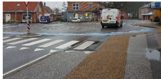
Cykelstien er trukket helt frem til fodgængerfeltet, parallelt med bilernes kørespor. Det kan mindske bilisternes opmærksomhed på cyklister.
