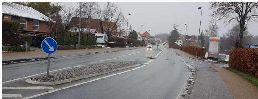
Midterhellen ved Jægersprislejren kan gøres mere synlig ved hjælp af N42 (kantafmærkningsplader) under D15,3-tavlen.
