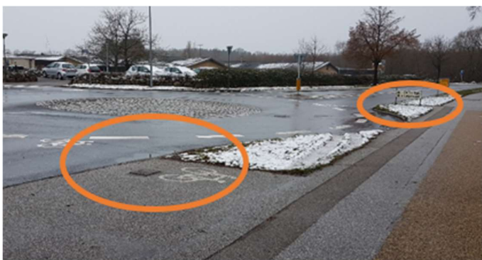
Nord for rundkørslen ved Parkvej ligger stien i et højere niveau end kørebanen. Det betyder, at cyklister til og fra Parkvej kommer meget overraskende for bilister ind i og ud af rundkørslen på Hovedgaden fra øst mod vest.
