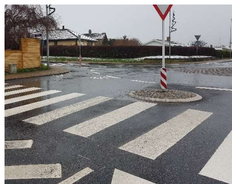
Begrænset oversigt fra Hovedgaden Øst mod Thyrasvej gør det meget svært for bilister at orientere sig om trafik fra Thyrasvej.
