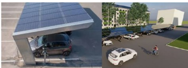
Figur 1: Eksempel på solceller på overdækning.
