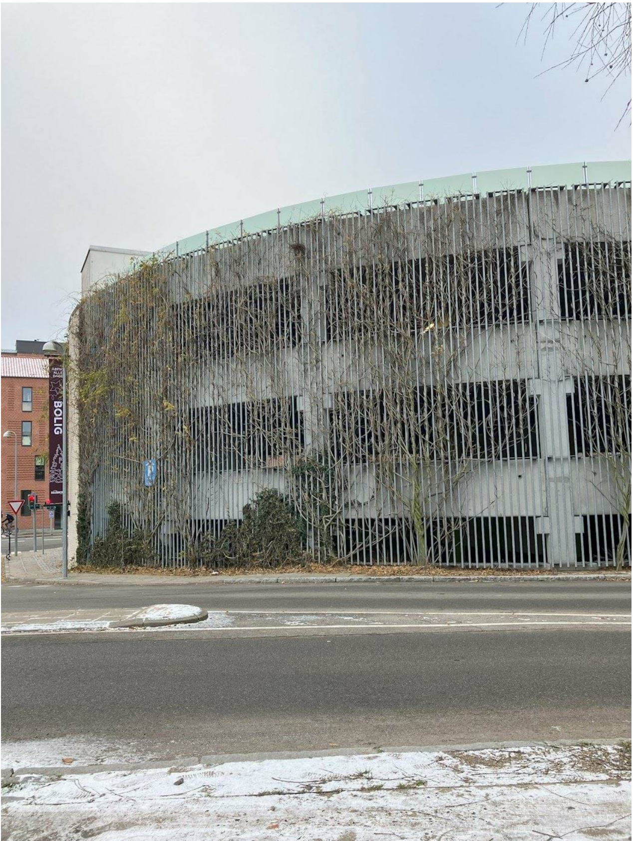
Parkeringshusets facader med slyngplanter
