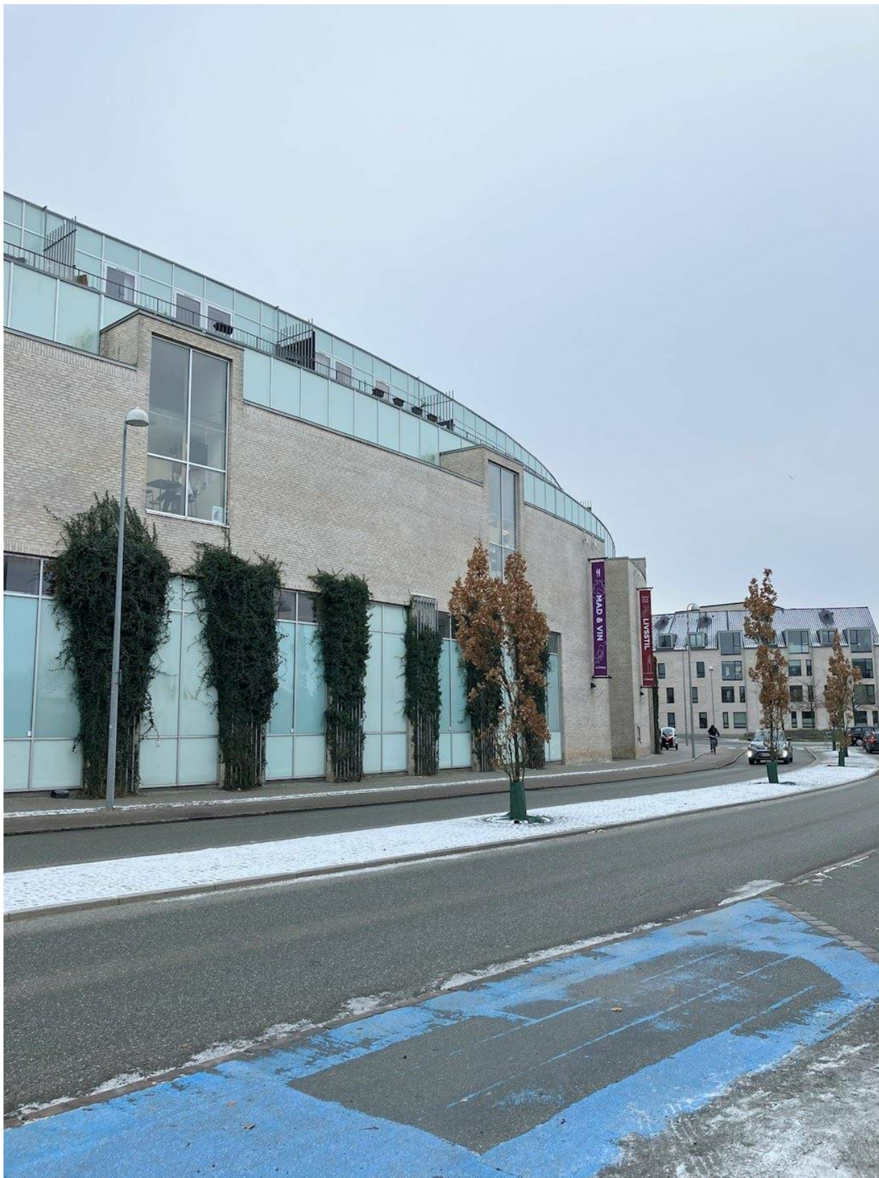
Butikscenteret med boliger på etage 3
