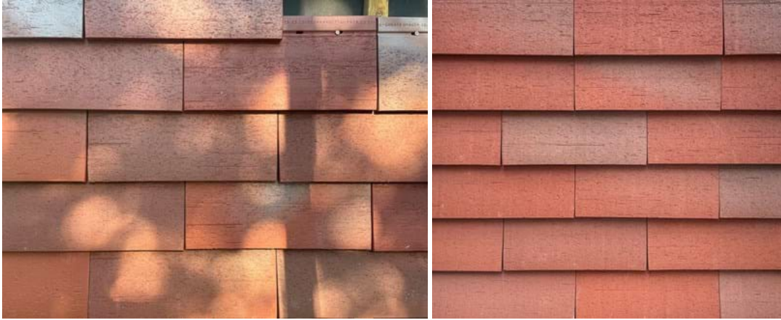
Figur 1. Princip for skærmtegl.
