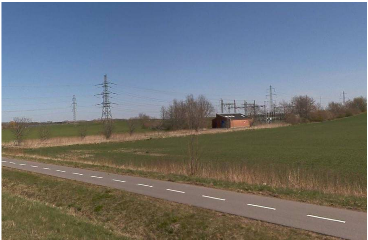
Foto 2: Viser det eksisterende højspændingsanlæg samt eksisterende forhold ved lokalplanområdet.
