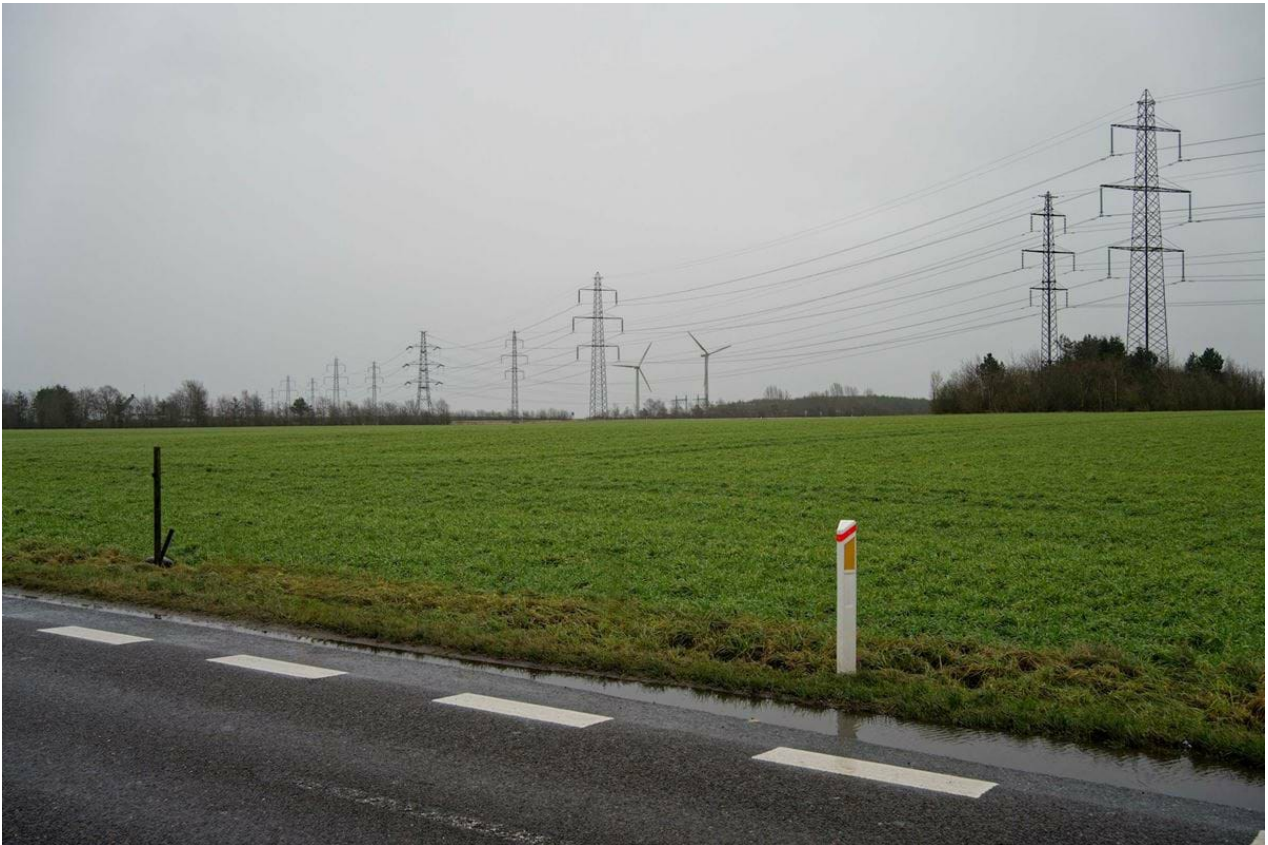
05 Eksisterende forhold set fra Dysagervej
