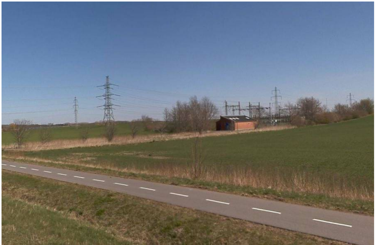
Foto 2: Viser det eksisterende højspændingsanlæg samt eksisterende forhold ved lokalplanområdet. Fotoet er taget fra sydvest fra Lyngerupvej.
