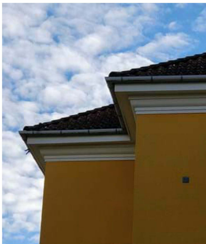
Foto - Profileret gesims på bygningen fra 1926
