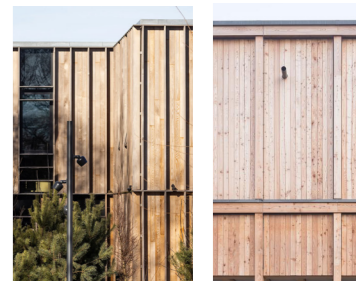
træbeklædning i varme toner
