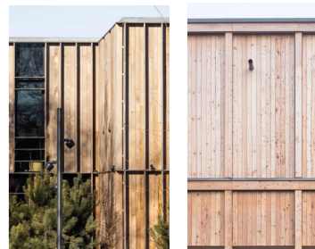
træbeklædning i varme toner
