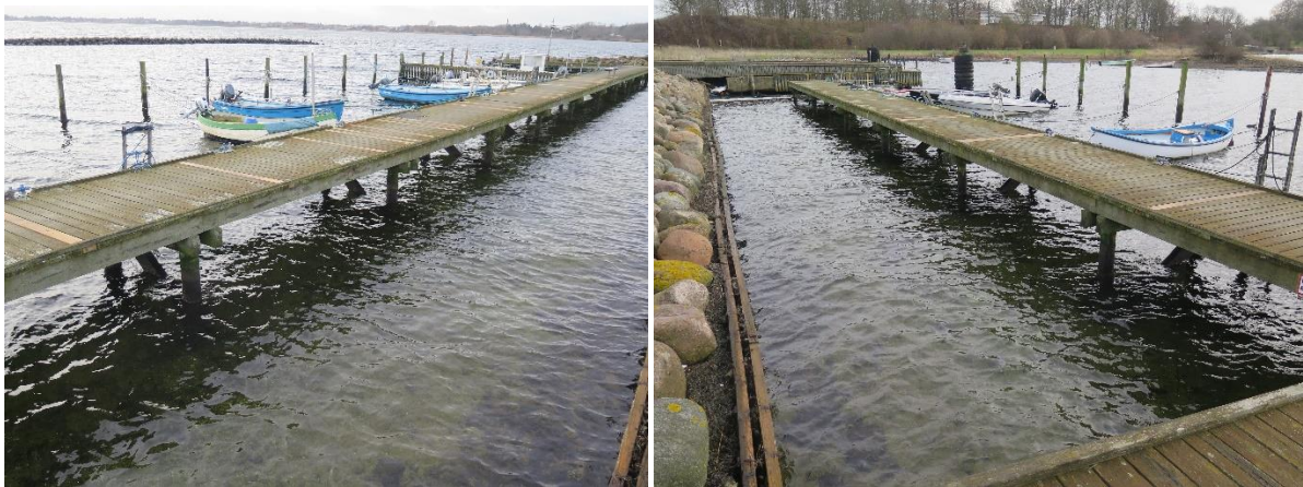
Figur 22: Anløbsbro med skråafstivning og nye gang brædder.
