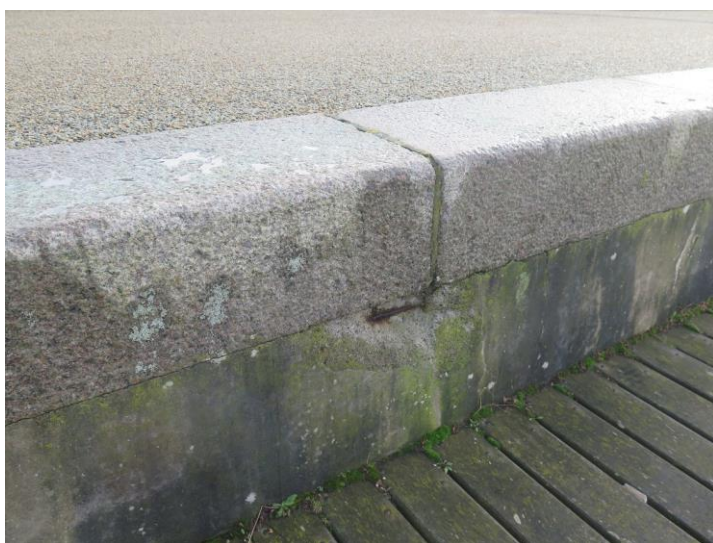
Figur 11: Boltlagt armering.
