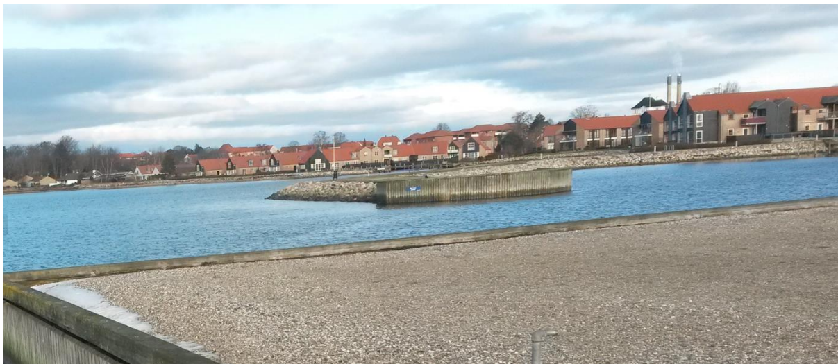
Figur 14: Operakajen. Åbning mellem hammer og spuns
