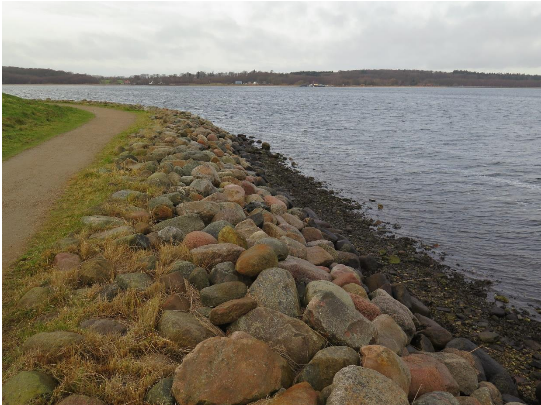
Figur 24: Stenskråning ved tippen.
