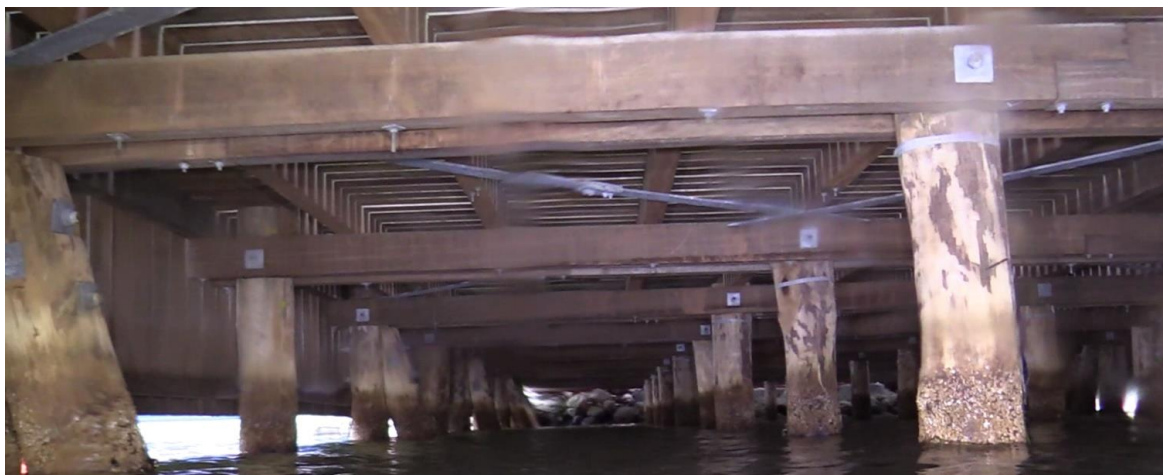
Figur 9: Undersiden af anløbsbro står fint. Som ny.
