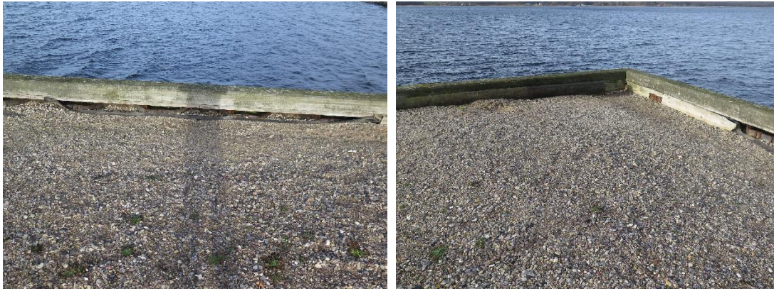
Figur 14: Operakajen. Åbning mellem hammer og spuns
