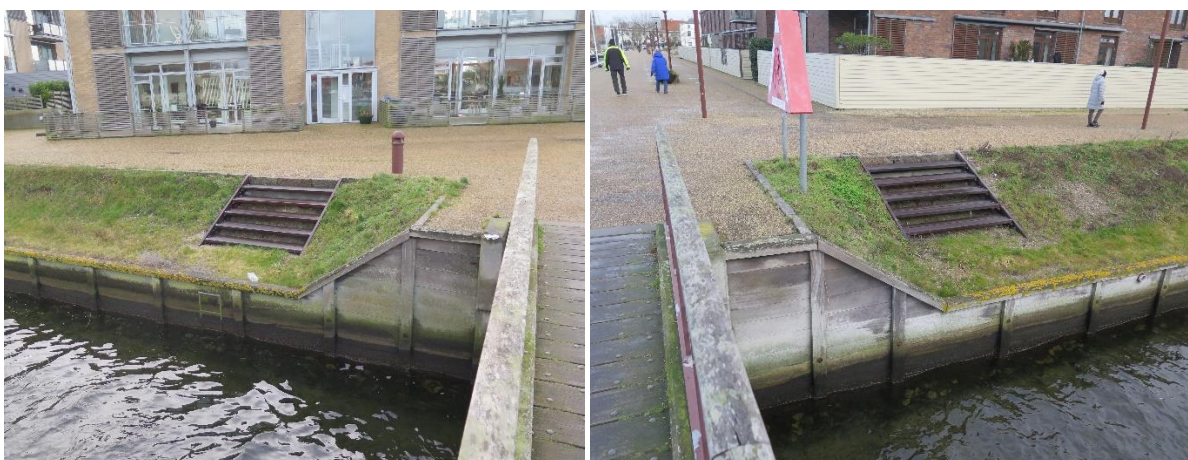
Figur 19: To nye trapper ved kanaludløb.
