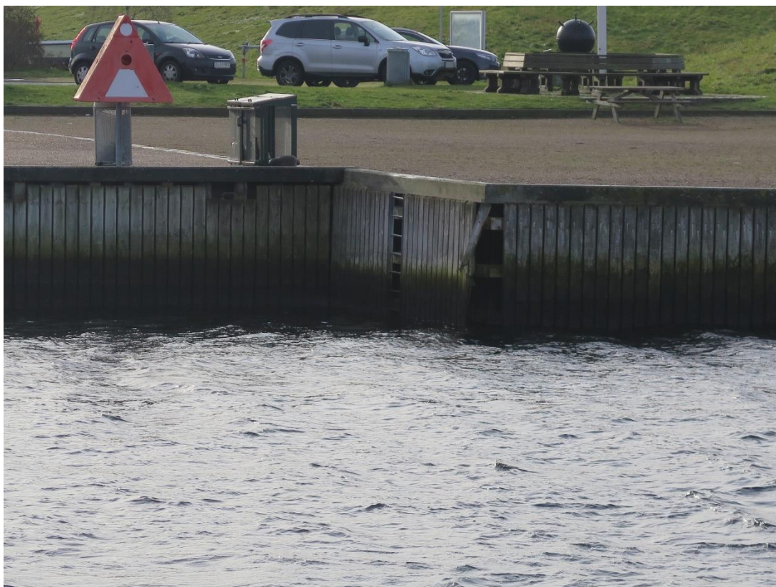
Figur 16: Lodrette beklædnings brædder er revet af. Operakaj.
