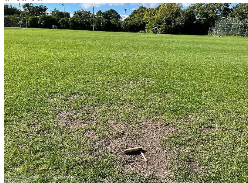
Figur 77: Kraftig gennemslidning i et gammelt målfelt på 3,7 cm i dybden (se næste billede)
