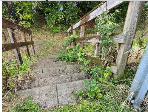
Figur 165: Brombærbuske og ukrudt bliver ikke fjernet på trappen op til banen.
