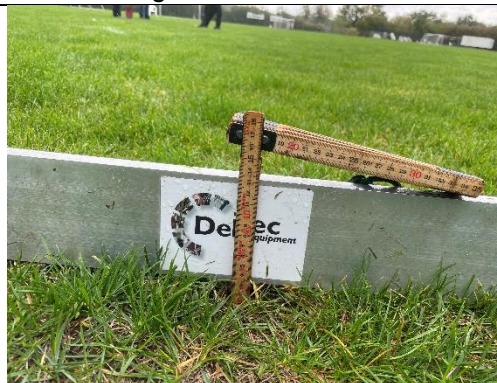
Figur 190: Der var mange mindre ujævnheder på op til 2 cm under 3 meter retskede. Jeg kunne også oplede større ujævnheder. Her en ujævnhed på 3,4 cm.
