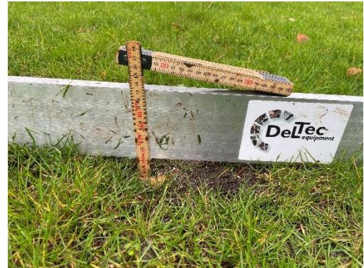
Figur 143: Mange ujævnheder op til 3,5 cm under 3 meter retskede.
